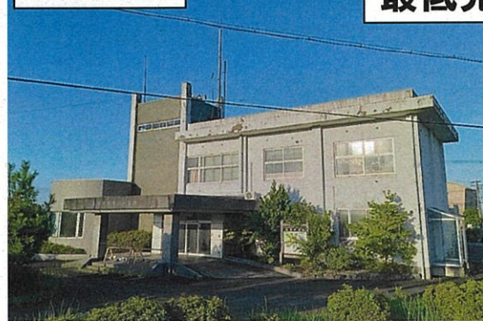
北東側より撮影
